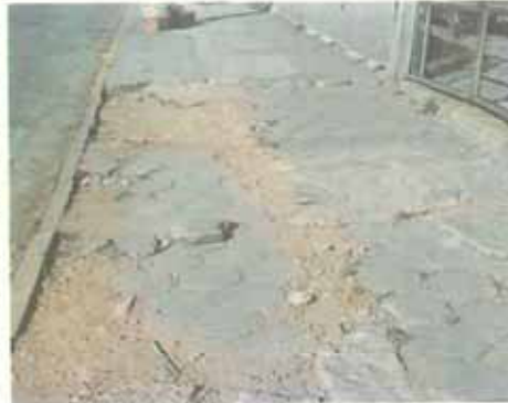
FIG. 2 — PISOS RACHADOS
